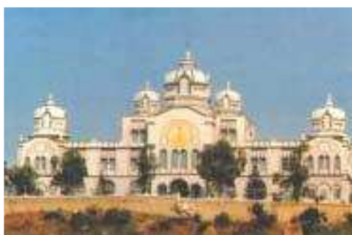
Bâtiment administratif, Université Srī Sathya Sai.
